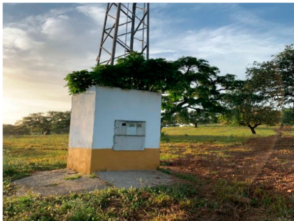
Ilustración 10: Centro Transformador de MT a BT
